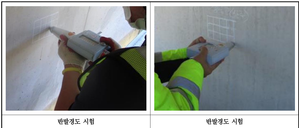
【사진 4.4.2】 반발경도시험 현장사진
