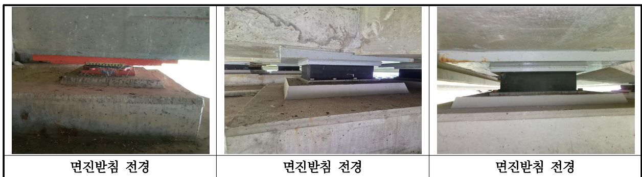
【사진 4.3.39】 교량받침 전경
