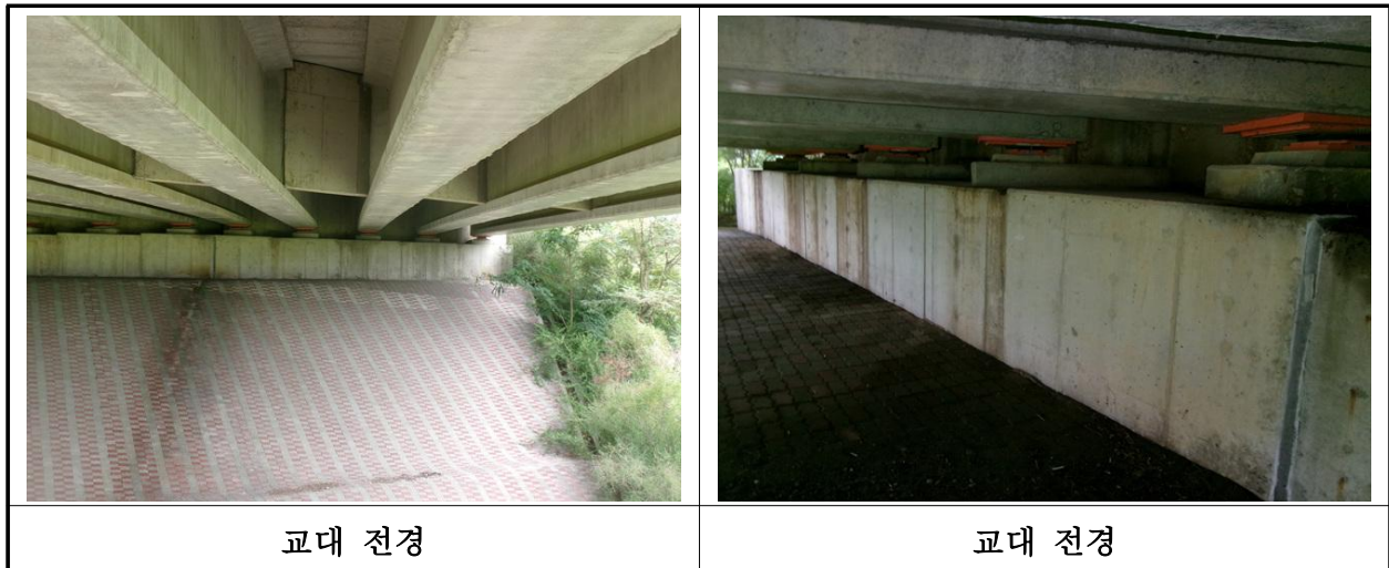
【사진 4.3.8】 교대 전경
