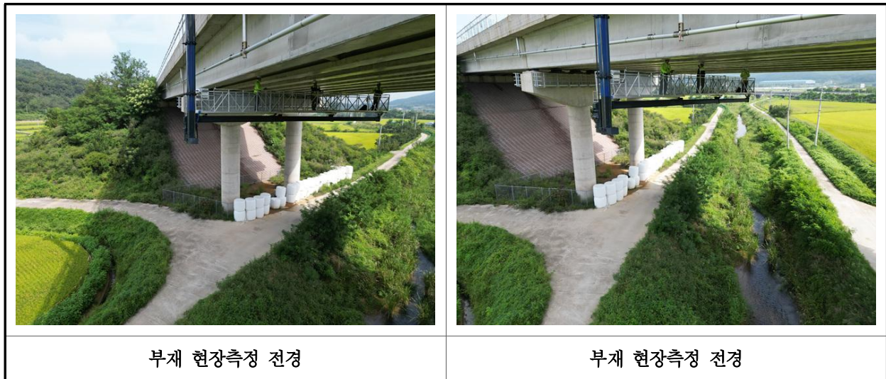
【사진 5.2.1】 부재 현장측정 전경
