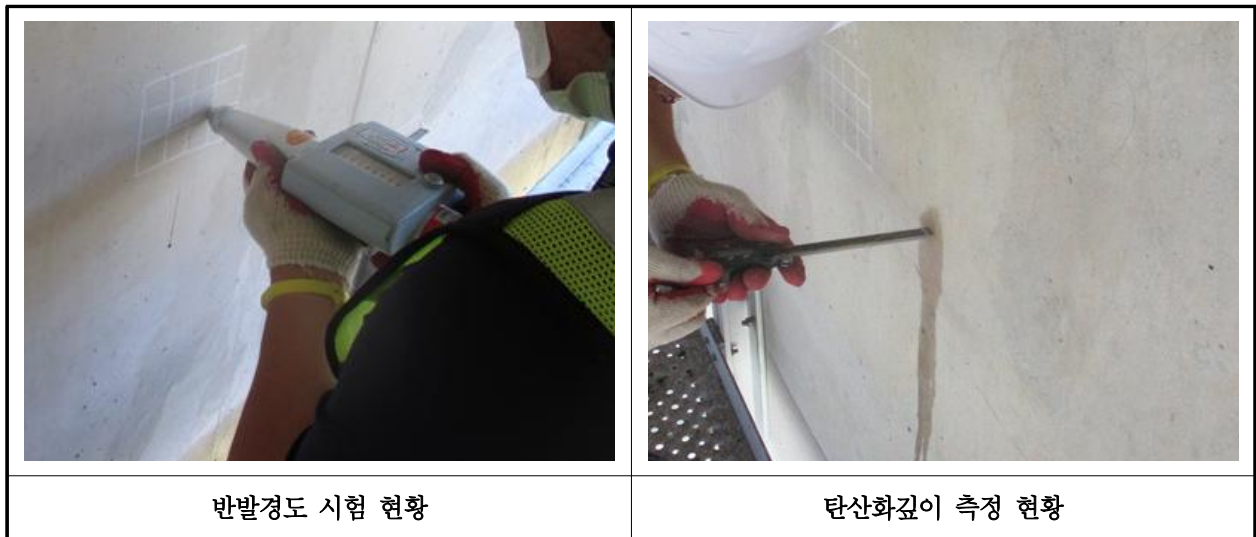
【사진 4.4.1】 콘크리트 내구성조사 현황
