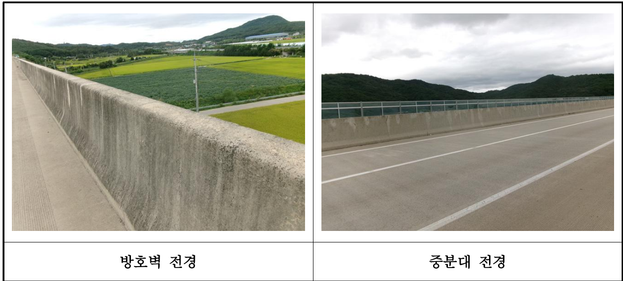
【사진 4.3.24】 방호벽 및 중앙분리대 전경
